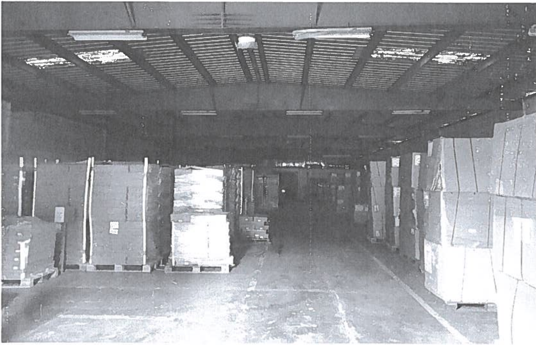
DESCRIPCIÓN DE LA PROPIEDAD. NAVE No. 5.
