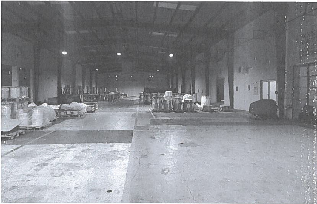
DESCRIPCIÓN DE LA PROPIEDAD. NAVE No.9.
