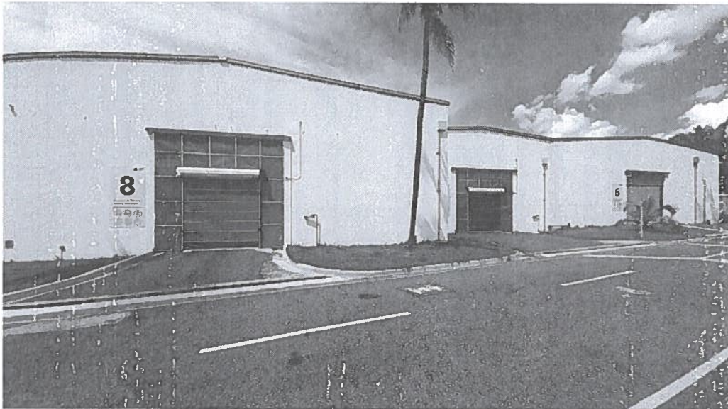
DESCRIPCIÓN DE LA PROPIEDAD. VISTA PANORÁMICA NAVES No.6 al No.8
