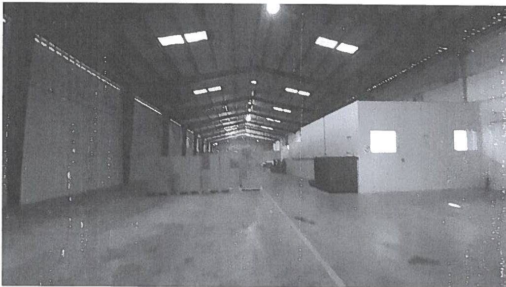
DESCRIPCIÓN DE LA PROPIEDAD. NAVE No.12.
