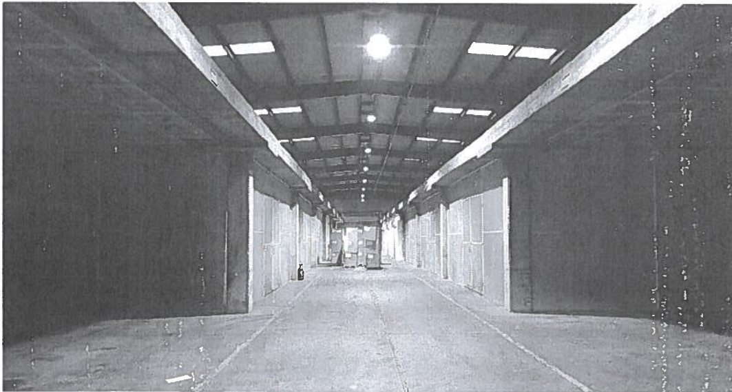
DESCRIPCIÓN DE LA PROPIEDAD. NAVE No. 6.
